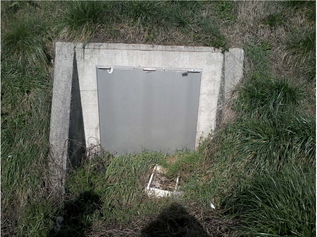
Figura 2-2 - Scarico presidiato area Coop
